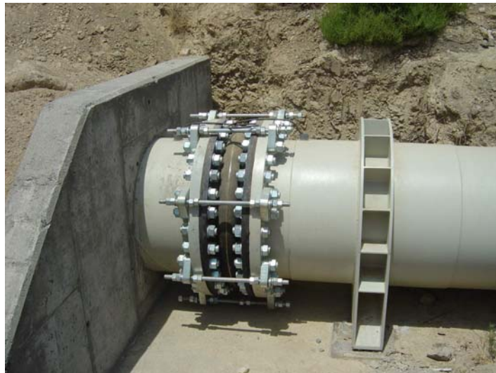
Compensador de dilatación con limitadores de recorrido
