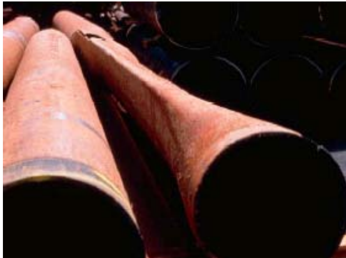
Colapso de tubería de acero por depresión interior
