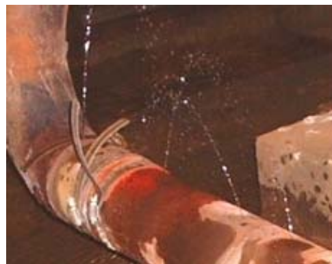
Patología por corrosión generalizada en tubería de acero
