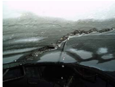
El mismo tipo de rotura del croquis anterior, sobre una tubería instalada mediante hinca
