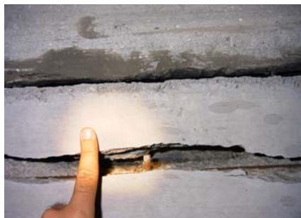
Tres fases de patología por el mismo problema de falta de armadura en la junta
